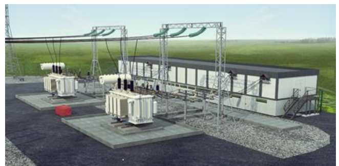
Рис. 3. Цифровая модель главной понизительной подстанции горного предприятия для тренажерной подготовки
