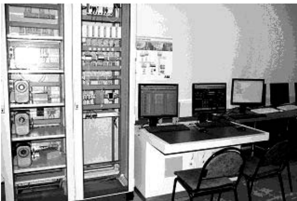
Рис. 2. ПТК Freelance 800F (ABB, Германия)
